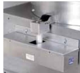
**Trampa de Grasa** — Es un contenedor de aluminio diseñado para retener la grasa y evitar derrames en la superficie del techo.
